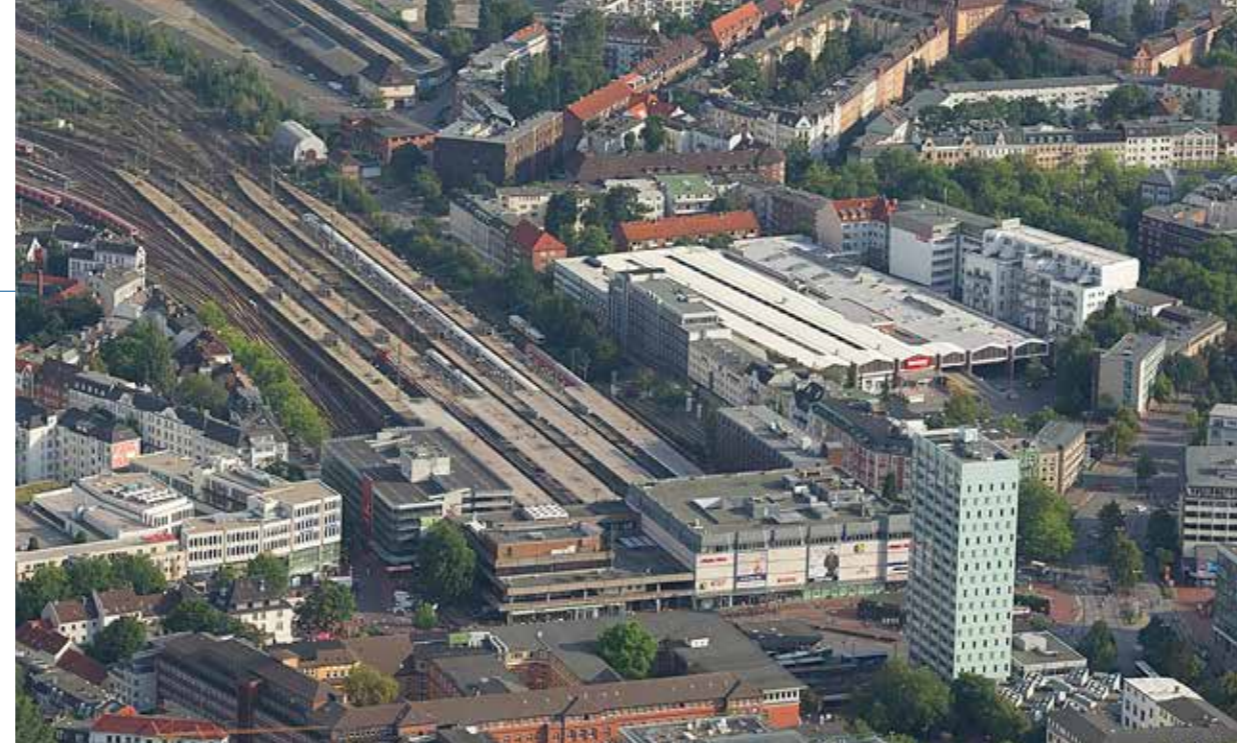
Das erste eigene Geschäftsgebäude direkt neben den Gleisen des Altonaer Bahnhofs
