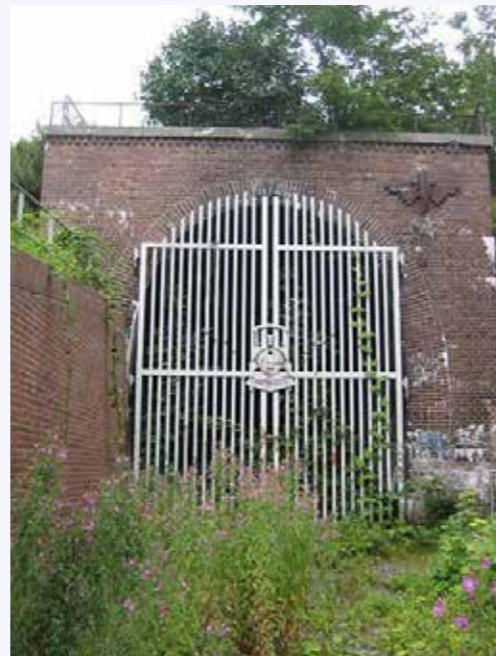
Südportal des Schellfischunnels in Hamburg-Altona
