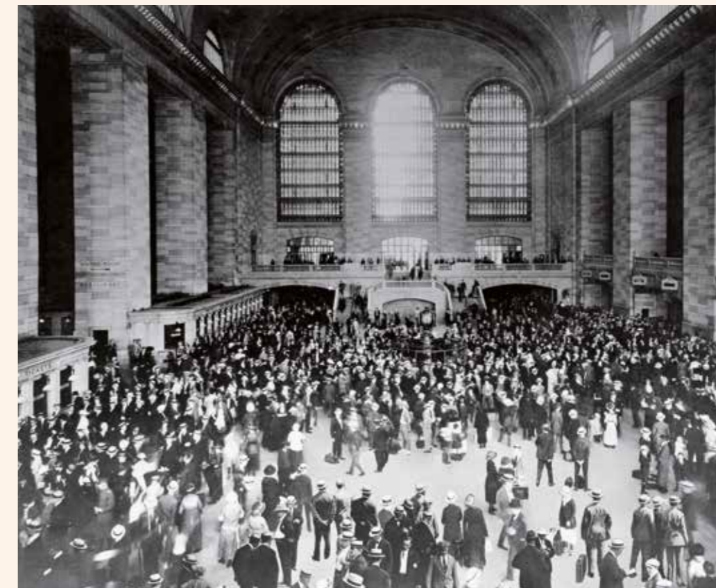
Die Halle des New Yorker Grand-Central-Bahnhofs
